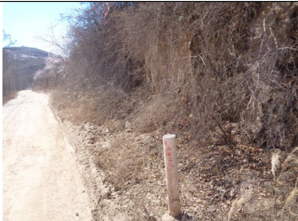
道路恢复状况
