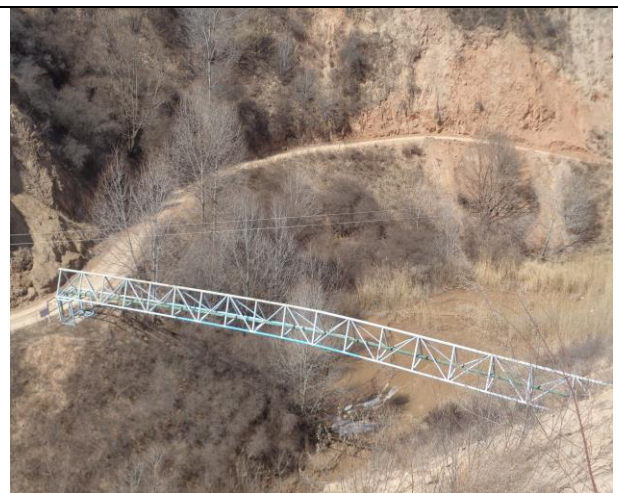
薛 4 外输管线恢复状况
