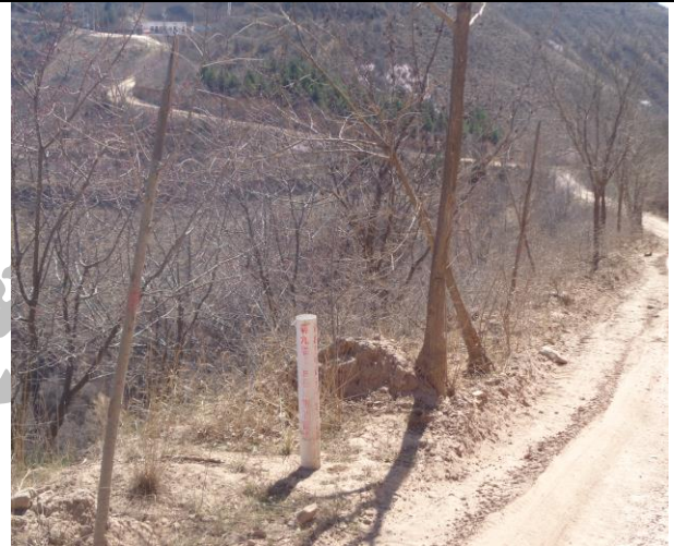
薛 11 至薛 4 转管线恢复状况
