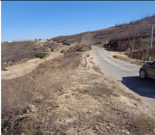
薛 10 及管线恢复状况
