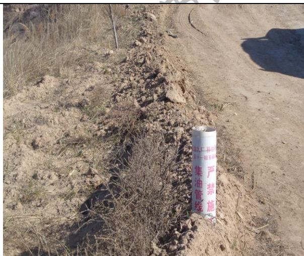
薛 9 管线恢复状况
