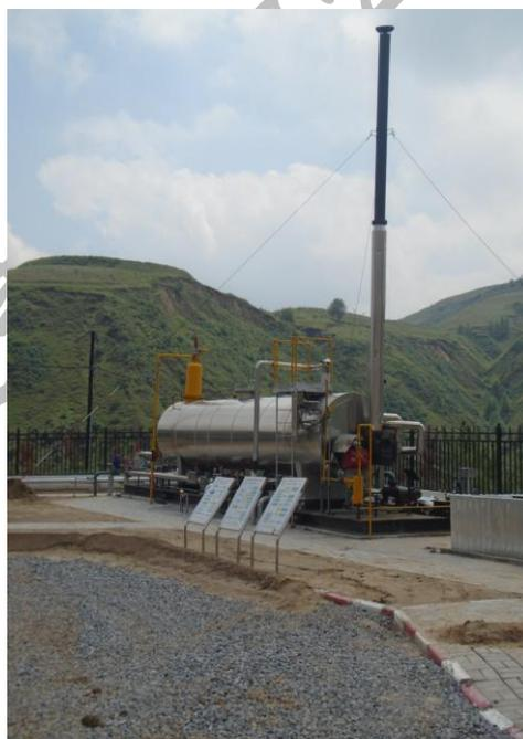
1台水套加热炉（排气筒高度8m）
