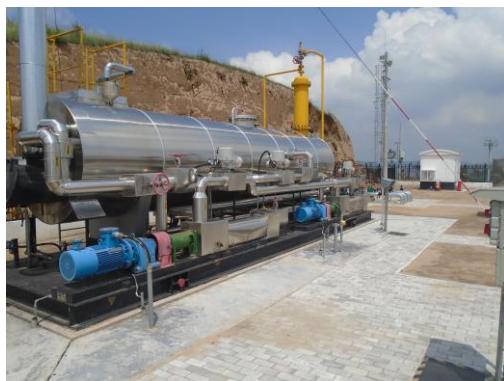
1台水套加热炉（排气筒高度8m）
