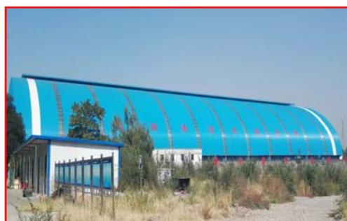
图 6（1）某项目钢网壳主体结构
