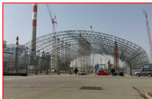
图5（2）预应力管桁架现场施工图
