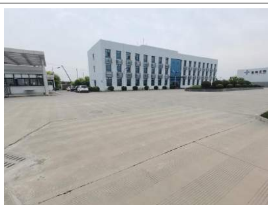
厂区道路工程
