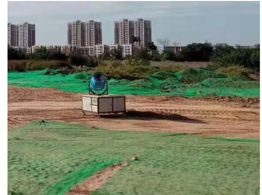
施工期喷淋洒水装置
