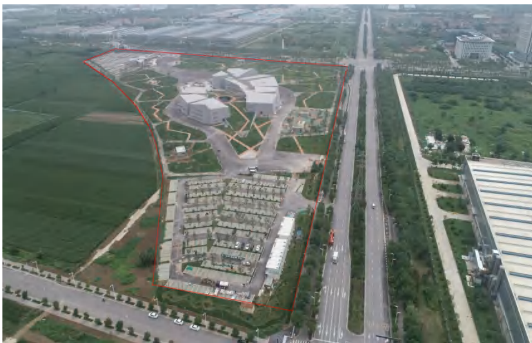
项目施工现场全图（拍摄时间 2021 年 9 月 2 日）
