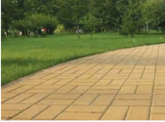
透水材料铺装
