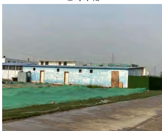
施工生产生活区现状
