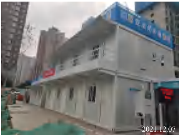
项目区施工生产生活区
