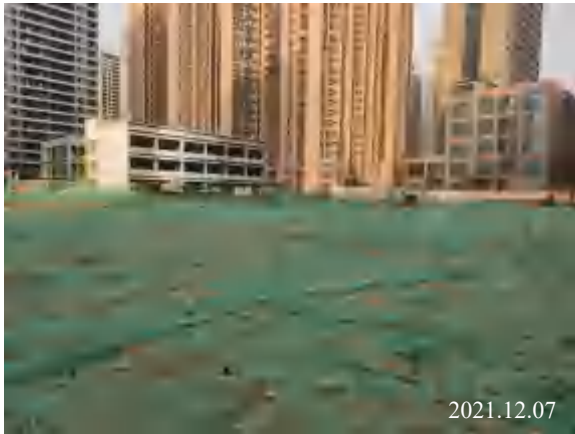
项目区临时苫盖
