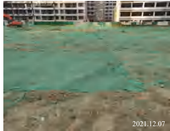
项目区临时苫盖
