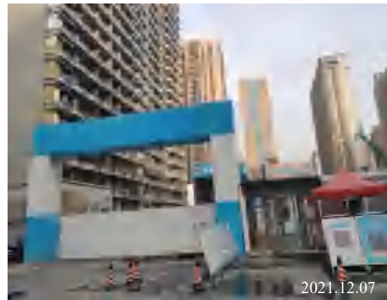
项目区西侧施工出入口
