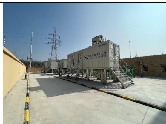
开关站内设备
