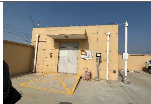
本项目依托危废暂存间
