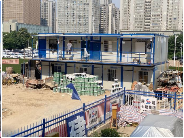
项目区施工生产生活区
