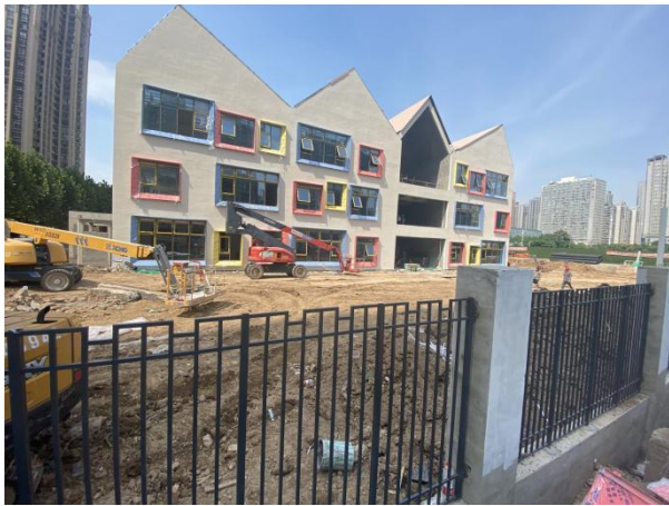
项目区施工现状
