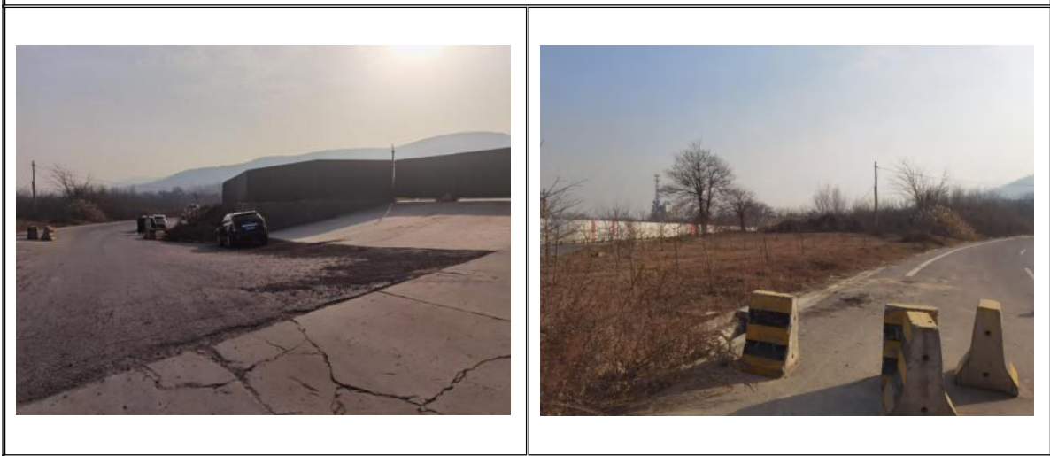
项目终点现状
