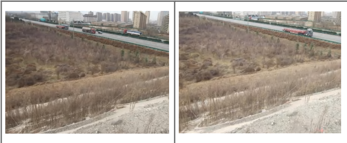
道路骨架护坡及绿化
